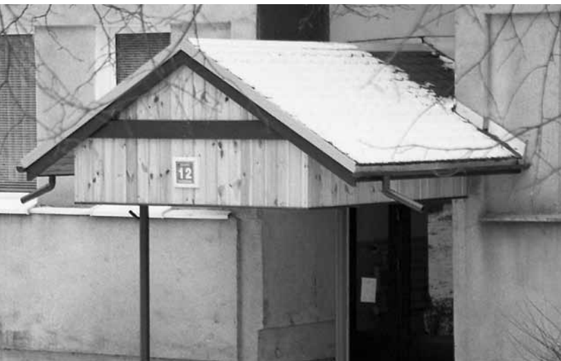
Wejścia do klatek schodowych w budynkach osiedla "O", projekty i realizacje z lat 1998 – 2004
