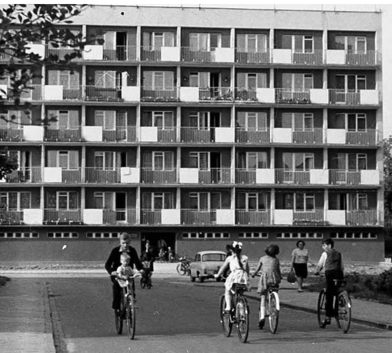
Budynek mieszkalny przy ulicy Bukowej w Tychach, 1964
